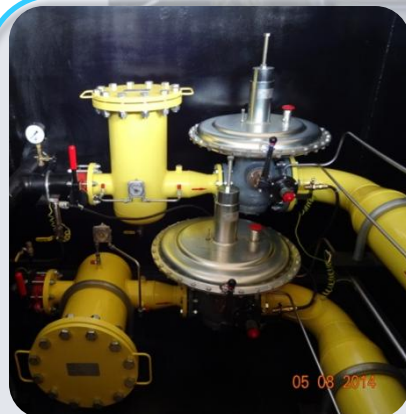
ШРП в исполнении ПР – для подземного размещения
